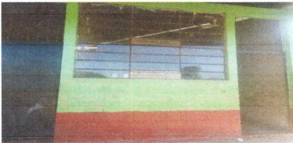
Foto 5: cambios de ventana por balcones
