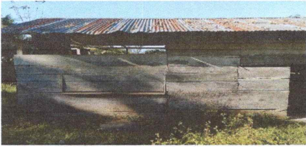
Foto1: Cambio del entechado
